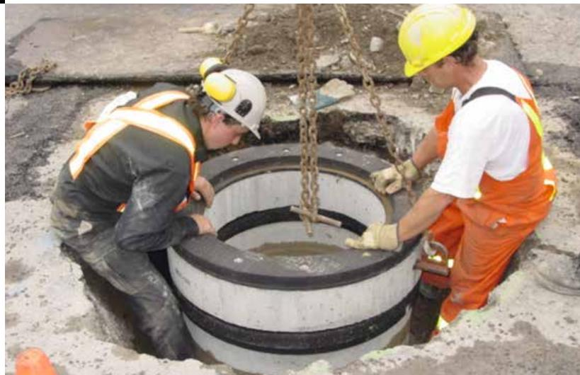
Grâce à sa conception innovante, Flex Frame™ absorbe la tension sur le couvercle de fonte lors du passage des véhicules, protégeant ainsi la chaussée des fissures et évitant les réparations coûteuses.
